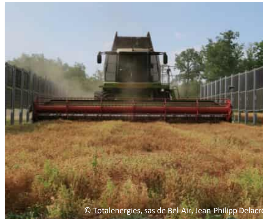
APV-Anlage Channay (FR); ca. 237 kWp und 10 m Reihenabstand.
