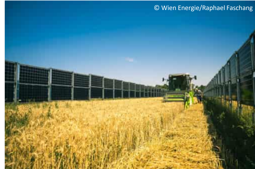
APV-Anlage Wien (Schafflerhofstr.); ca. 160 kWp und 9 m Reihenabstand.
