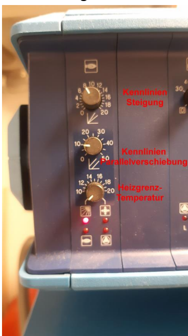
Typische Einstellknöpfe für die Kennlinie („Heizkurve“) einer herkömmlichen Heizanlage. Einzelheiten finden Sie in der Bedienungsanleitung Ihrer Heizungsregelung oder des Heizkessels.
