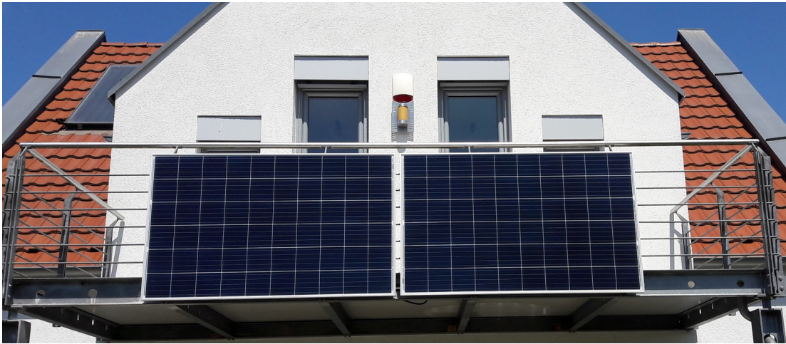
Bild: Balkonsolarmodule im Einsatz (Quelle: Energiewende ER(H)langen e.V.)
