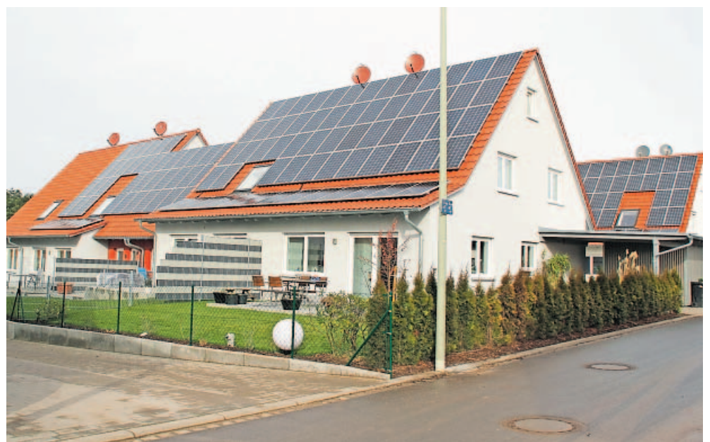
Solarmodule auf allen Dächern: Das Wohngebiet am Gerbersknock.
